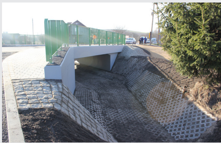
Przebudowa mostu w ciągu drogi powiatowej nr 1767 S Pilica- Żarnowiec w miejscowości Stawniów - 764.850,00 zł
