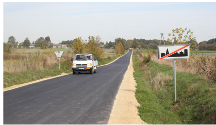
Remont drogi powiatowej Kleszczowa- Podleśna - łączny koszt: 1.394.184,25
