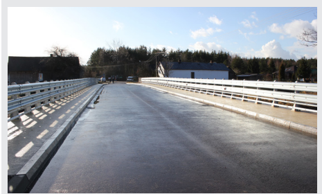
Przebudowa mostu na rzece Pilica w ciągu drogi powiatowej nr 1106 S relacji Gródek – Brzostek – Staryzny-Szczekociny w m. Przytyk - 1.794.331,11 zł
