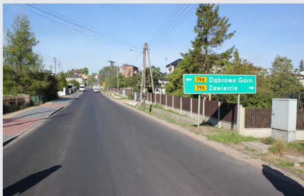
Przebudowa odcinka drogi powiatowej nr 1708 S w Ciągowicach. Wyremontowano 7,5 km nawierzchni wraz z chodnikami. Wartość zadania 3.557.255,51 zł
